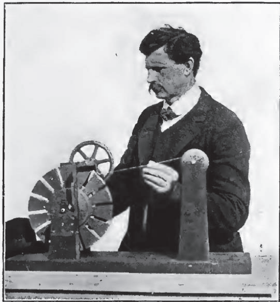
図 68-11. 二次コイルの巻き付け. 交換可能二次セクションをもつ二次コイルの 1/2 セクションの製作.
